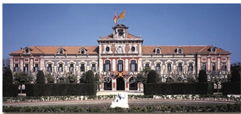
Figura 11: Fachada de la Academia desde el parque de la ciudadela de Barcelona, sede del actual Parlamento.
